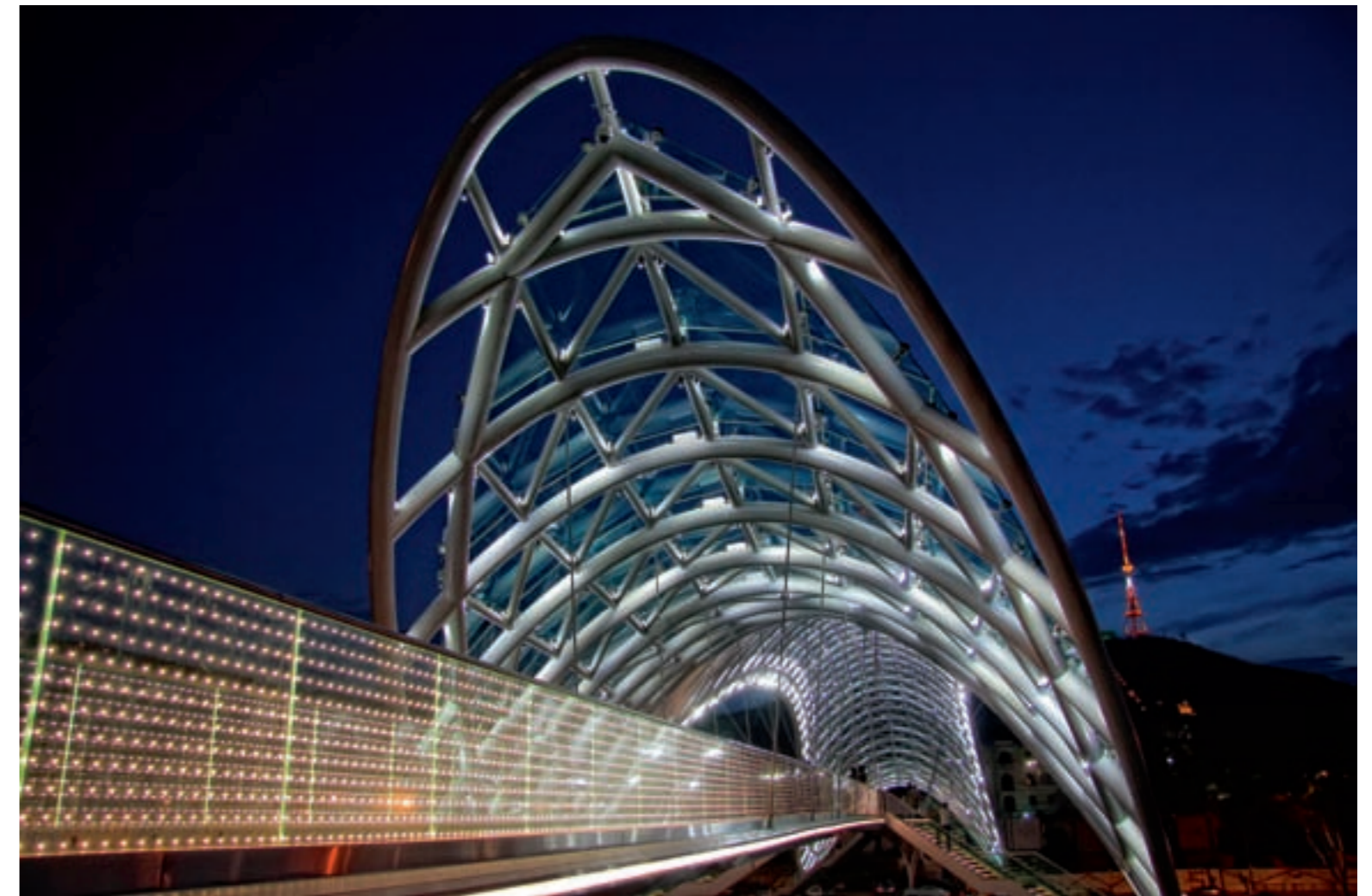
De met LED's uitgevoerde borstwering wordt gebruikt om de wandelaars op de brug een interactieve lichtervaring te bezorgen.
