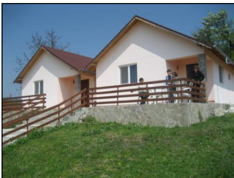
De twee bestaande huisjes in april 2010
